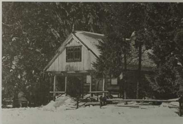
Budynek Babiogórskiego Parku Narodowego na Przełęczy Krowiarki (fot. P. Krzywda)
