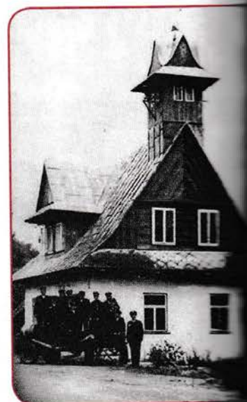
Budowa remizy OSP Lipnica Wielka – Centrum 1948–1949
