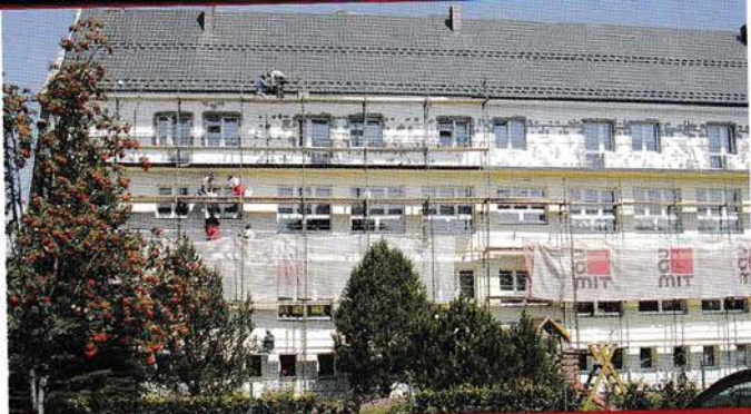
Remont Przedszkola w Jablonce
