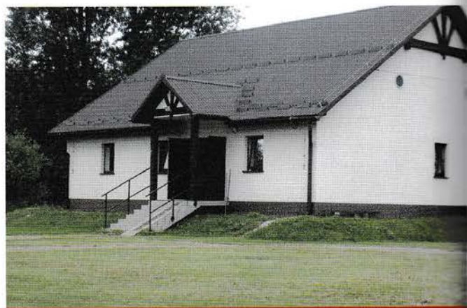
Budynek oczyszczalni „Wrzoso”
