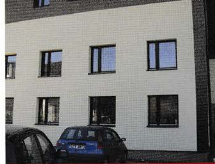
Termomodernizacja budynku wielofunkcyjnego w Koszarawie
