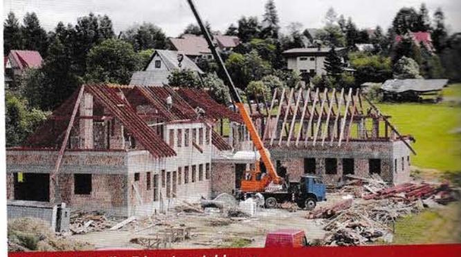
Budowa Ośrodka Zdrowia w Jablonce
