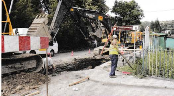
Budowa kanalizacji sanitarnej w Stryszowie
