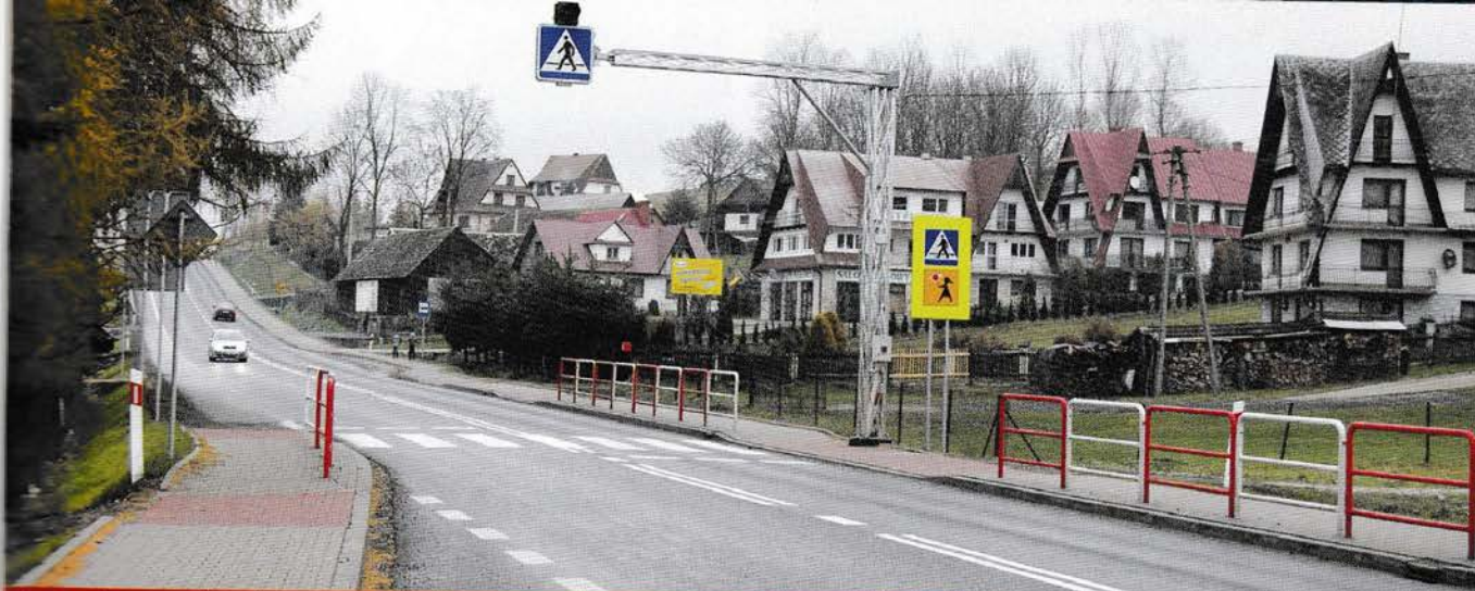
Zmodernizowana droga krajowa Nr 7 w Jablonce Matonogi
