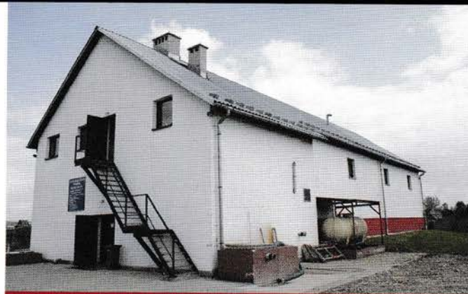
Oczyszczalnia ścieków w Lipnicy Wielkiej
