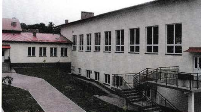
Sala gimnastyczna przy Szkole Podstawowej w Stroniu
