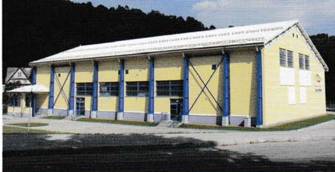
Hala widowiskowo-sportowa w Zawoi Centrum
