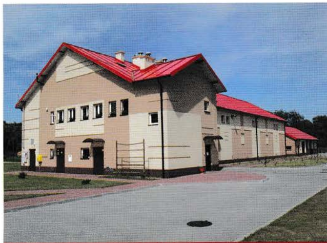
Zbiorcza oczyszczalnia ścieków w Stryszowie
